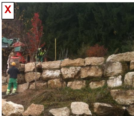
Enrochements de type cyclopéens
