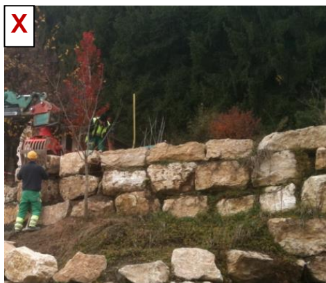
Enrochements de type cyclopéens
