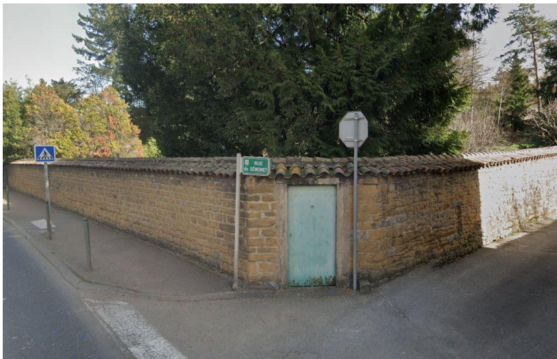
Murs en pierre à l'angle de la rue du Sémonet et de la R16
